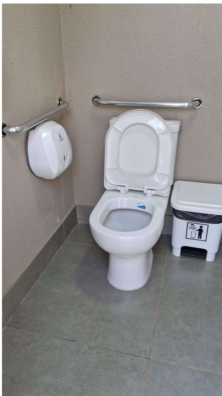
Foto 11 – Detalhe do sanitário do WC-PNE
